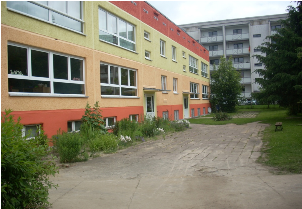
Abbildung 4: Rückseite des Kita-Gebäudes mit Terrassenfläche
